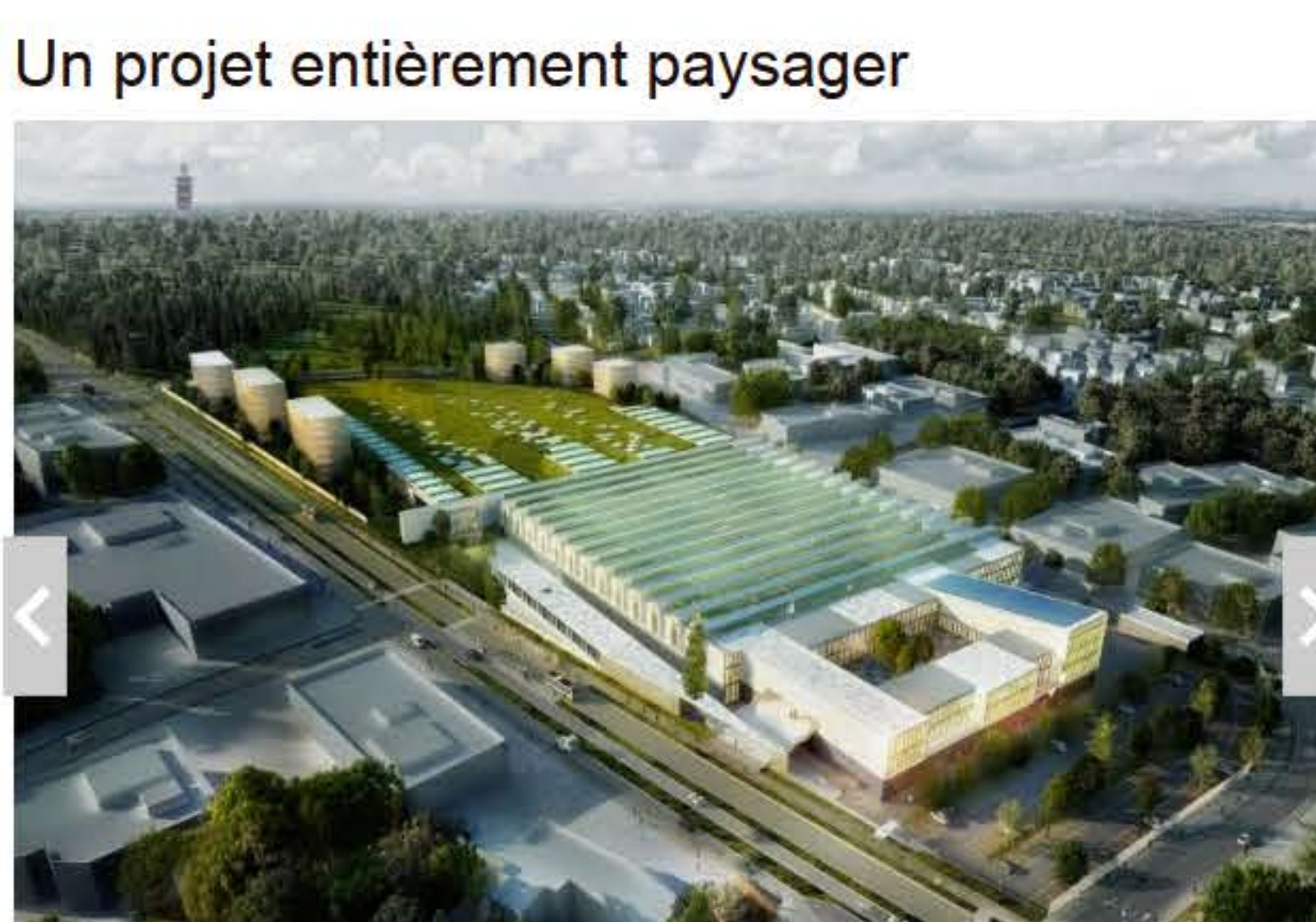
Grand Paris Express : réalisation du centre d'exploitation de Champigny-sur-Marne (Val-de-Marne) imaginé par l'agence Richez Associés © Société du Grand Paris - Richez Associés
