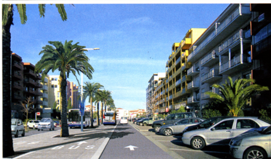
Boulevard Kennedy à Perpignan : état existant et projet. La ligne nord-sud du BHNS de Perpignan (coût 38 M€) se construit par phases pour éviter de pénaliser un trafic automobile très important. Un tiers du linéaire a été livré et le tout (10,4 km) le sera en 2014. Le bus empruntera un site propre sur deux tiers de son parcours. La SNC Lavalin et l'agence de paysage Alfred Peter en assurent la conception. Plus fréquenté, l'axe est-ouest bénéficiera d'un tramway d'ici 2017, qui desservira la gare. La place de Catalogne permettra la correspondance entre les deux lignes.
