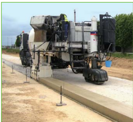
Avant la mise en œuvre de la couche de roulement, coulage du caniveau central en béton extrudé.
