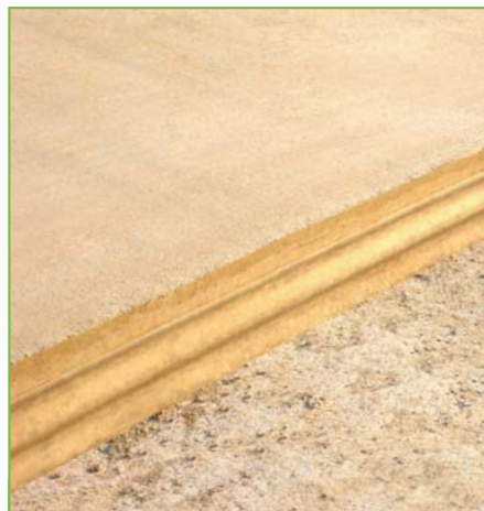
De couleur ocre, la couche de roulement a une épaisseur de 22 centimètres.
