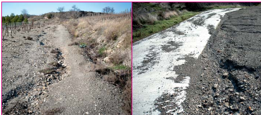
Les schistes des Corbières sont très sensibles à l'érosion. Sans chaussée béton, les chemins sont vite dégradés par les fortes pluies (à gauche). Alors que les voiries en béton résistent parfaitement aux caprices du ciel (à droite).
