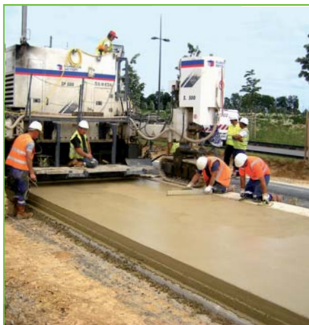
Mise en œuvre du béton armé continu sur 3,20 mètres de largeur.
