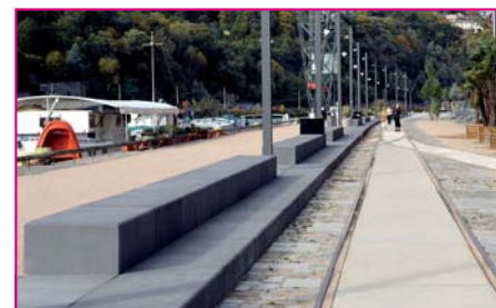
Les anciens rails du port et la banquette en béton, en étant parallèles, accentuent encore la linéarité du quai.
