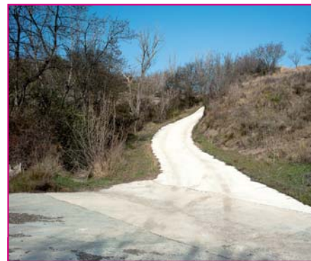
Une partie des caniveaux, guidant l'eau jusqu'au dispositif naturel d'évacuation, a aussi été réalisée en béton.
