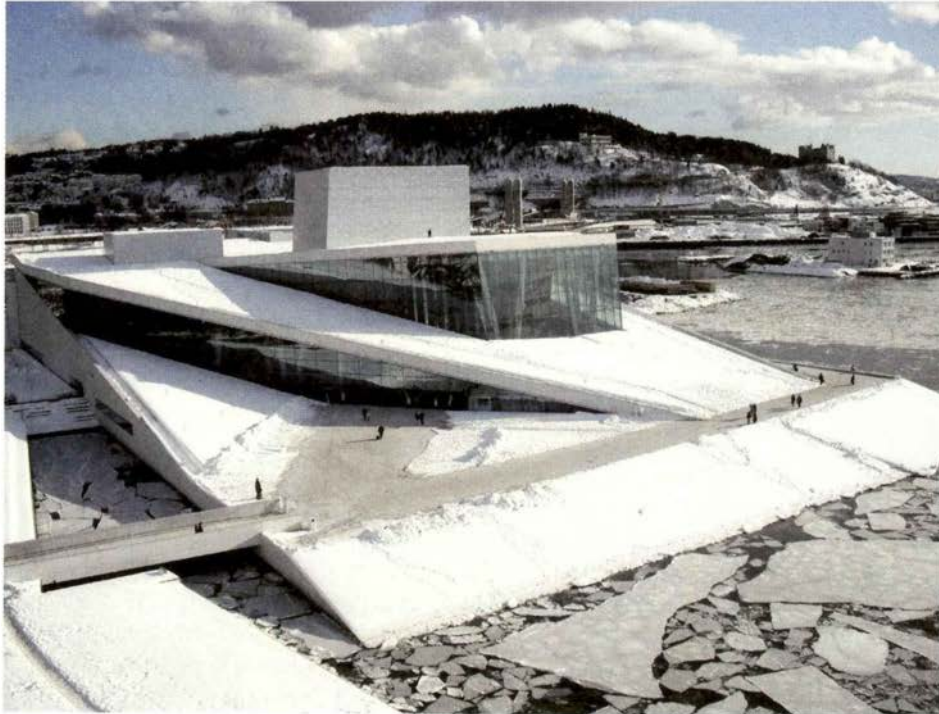
↑ Lieu de promenade, le toit de l'Opéra national de Norvège, Oslo, 2008, Snøhetta arch. Ph. © Birdseyepix.
