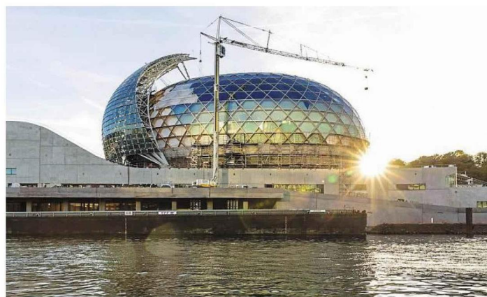
À Boulogne-Billancourt, la verrière de la Seine musicale, ici lors de l'intervention de l'entreprise vendéenne MTEchbuild, en 2016.
