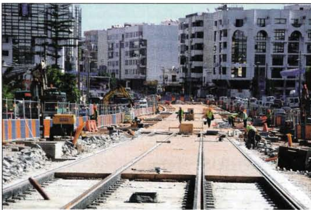
Prochainement, pour passer par le boulevard Abdelmoumen ou accéder via cette artère au boulevard Ghandi, la circulation automobile sera déviée vers le boulevard Hayani ou le boulevard Anoual (Ph. Jarfi)
